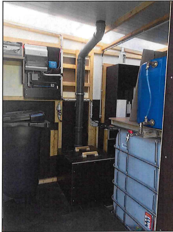
Darstellung des Depotinnenraums mit Förderband, Feststoffbehälter, Elektronik, Entlüftung und Regenwassertank
