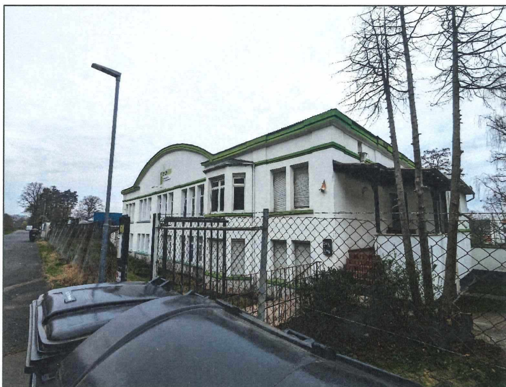
Straßen- bzw. Südostansicht des Bewertungsobjektes
